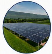
Centrales au sol
